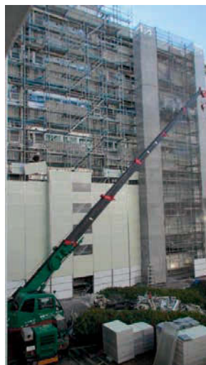
図 5.11 改修工事中の A 棟西側
