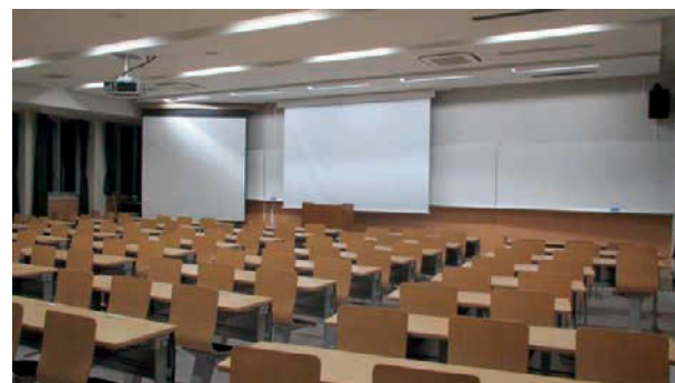
図 5.13 改修後の 101 番教室
